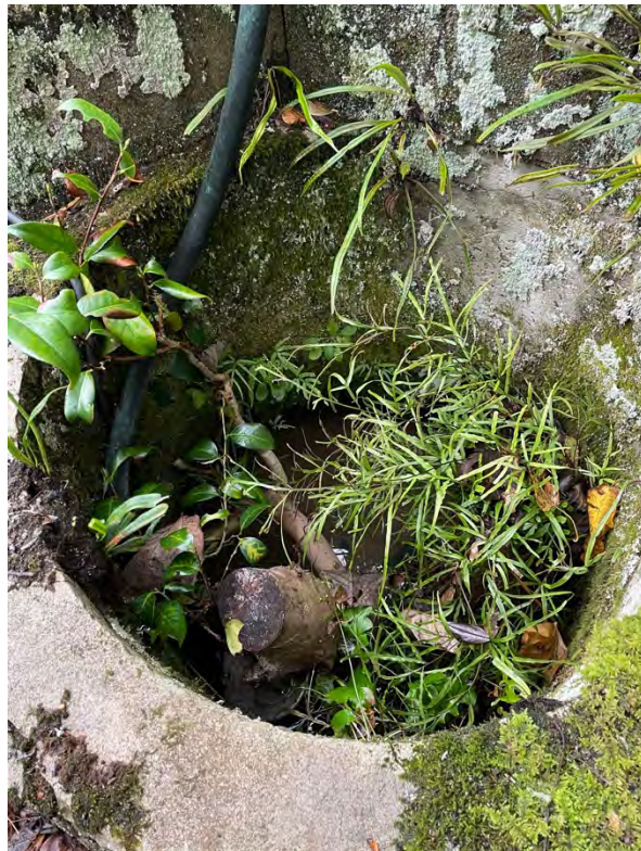
図 17 壱岐島の井戸の様子 上水道の普及により、壱岐島では井戸を使わなくなってしまった
