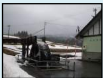
小水力発電(大)【上掛け水車型/750W/落差3m】
